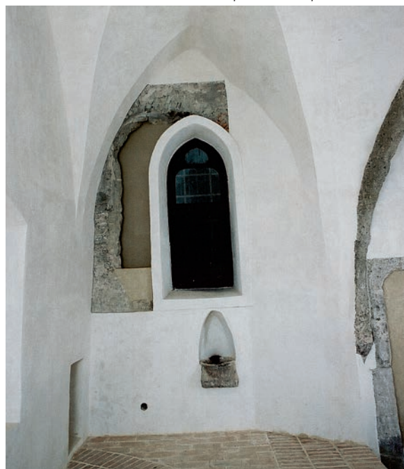
Pohľad na analytickú sondu pôvodného združeného gotického okna so sekundárnym oknom a mladším kamenným lavabom na severnej stene. Stav po reštaurovaní
