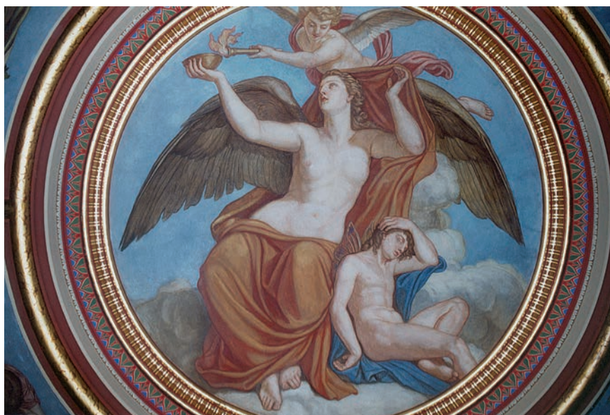
Detail stropu po reštaurovaní. Rekonštrukciou skorších pôvodných ornamentov maľba získala estetické kvality.
