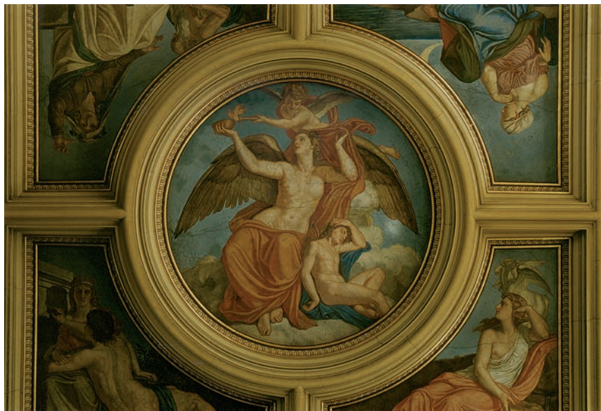
Centrálna časť stropu. Stav predreštaurovaním
