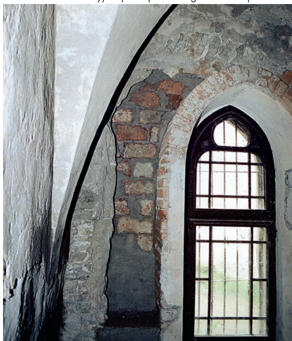
Celkový pohľad na sekundárne okno na severnej stene sakristie v severozápadnom rohu s tehlovou zámurovkou vyplňujúcou pôvodné gotické zdvojené okno
